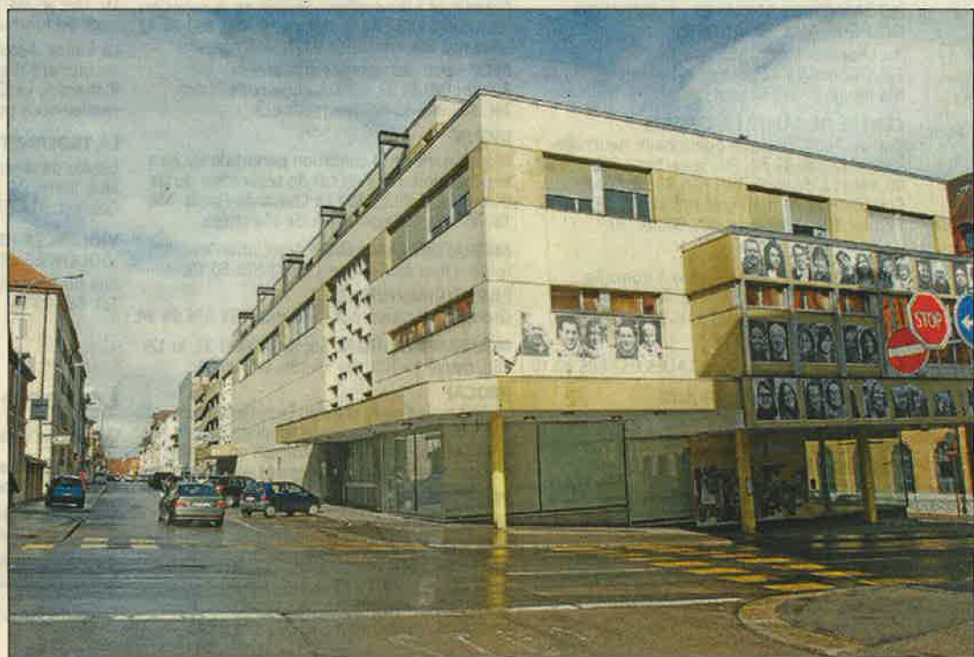
L'ancien magasin Top Tip, à La Chaux-de-Fonds, sera réaménagé en appartements et villas curbaines correspondant à la demande des résidents désireux de construire leur nid en ville? (ALAIN PRÊTRE)
