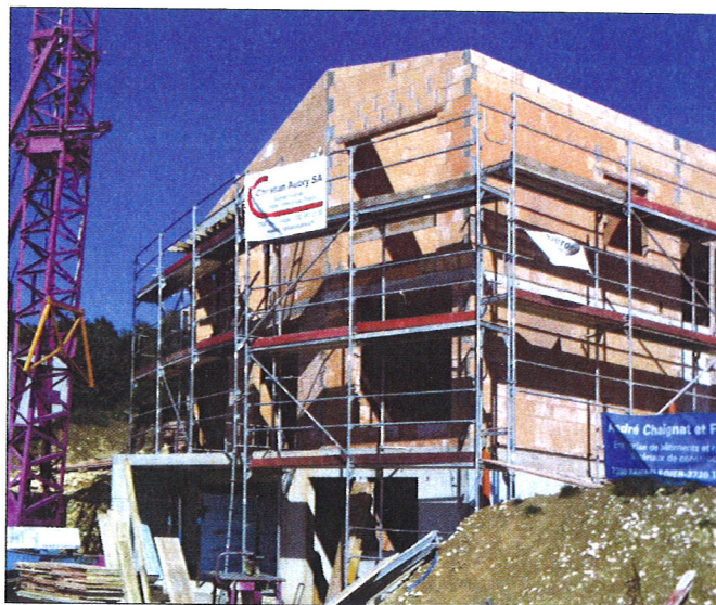
La structure et la maçonnerie sont en béton armé et briques en terre cuite.
